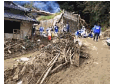
裏山からの土砂崩れ
