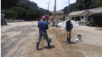
泥の除去作業
