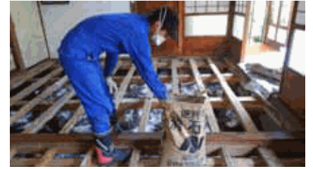
床下の消毒作業
