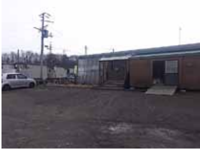
愛島東部団地仮設住宅
