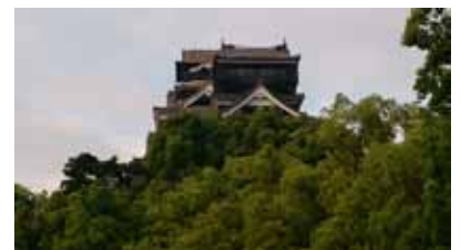
甚大な被害が発生した熊本城
