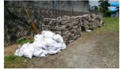
運び出したブロック片
