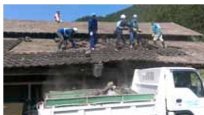
屋根瓦の撤去作業
