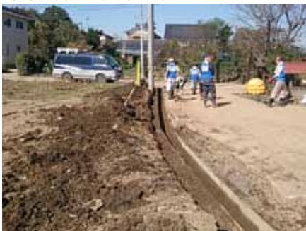
三坂地区 側溝の泥出し
